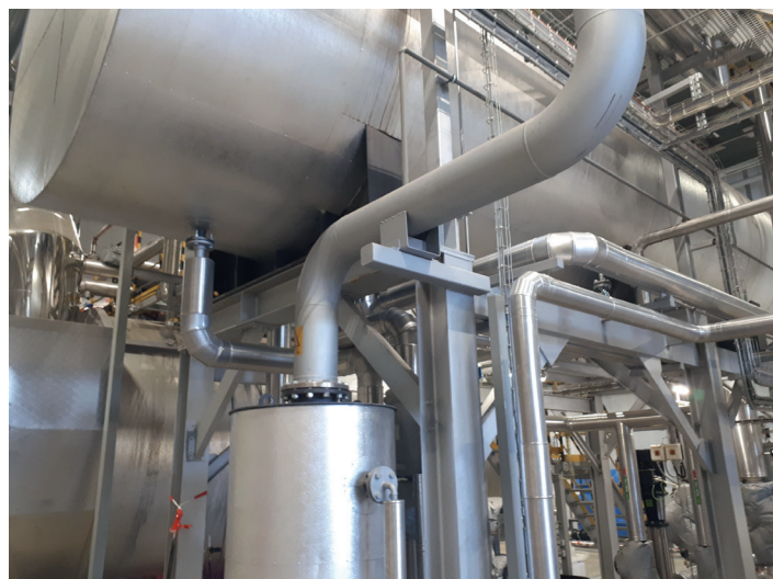
Калужская область Реконструкция паровой котельной с установкой утилизатора отходящих газов
