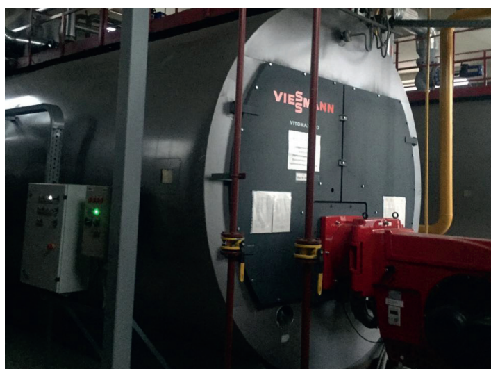
📍 Московская область Реконструкция котельной с паровым котлом 20 т/ч , и водогрейным котлом 10 МВт
