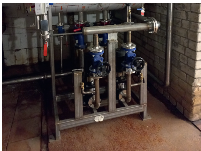
📍 Брянская область, Брасовский р-н Изготовление и поставка конденсатной станции объемом 0,6 куб.м, производительностью 8куб.м/час в комплекте с арматурой
