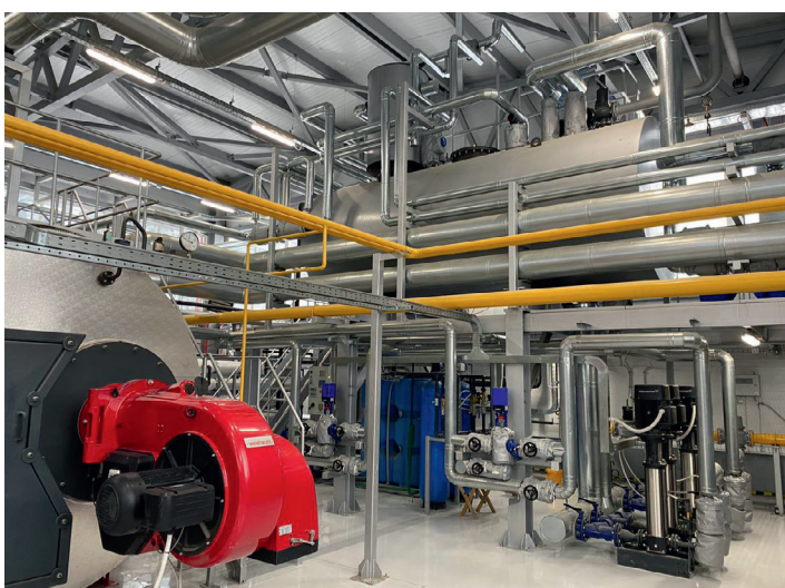
Курская область Изготовление и поставка оборудования для паровой котельной 12 т/ч
