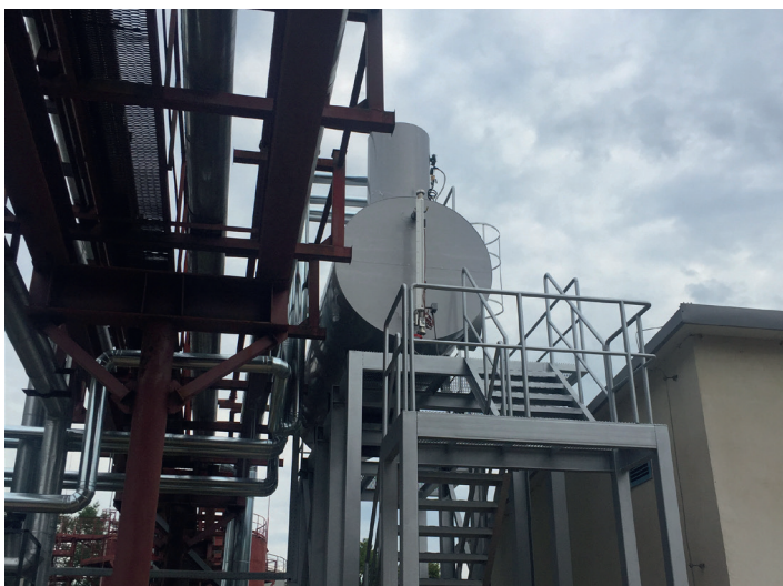
📍 Смоленская область Проектирование, изготовление и монтаж деаэрационного модуля ДА-8 для котельной
