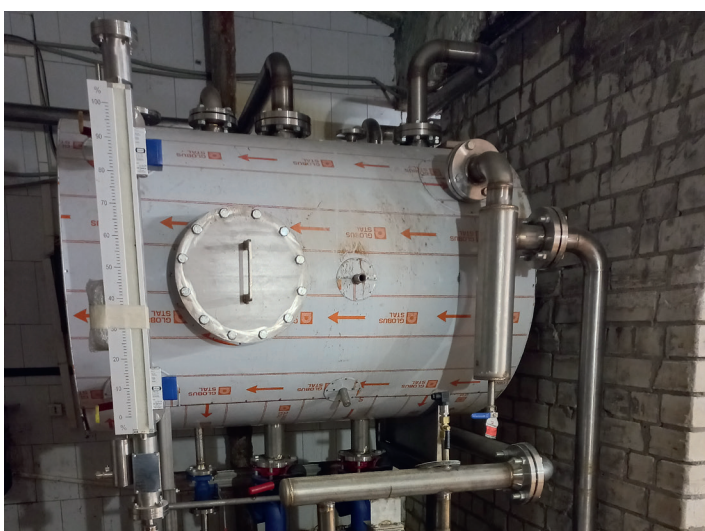
📍 Брянская область, Брасовский р-н Изготовление и поставка конденсатной станции объемом 0,6 куб.м, производительностью 8куб.м/час в комплекте с арматурой
