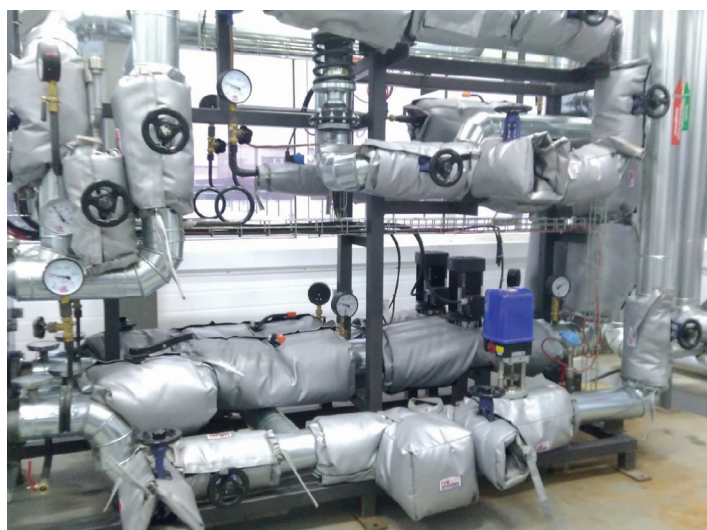
📍 Московская область Поставка Блочного теплового пункта для пищевого предприятия
