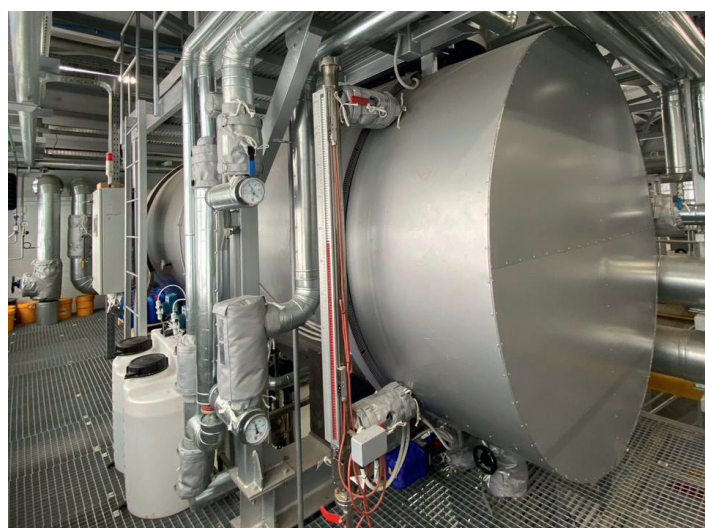
Курская область Изготовление и поставка оборудования для паровой котельной 12 т/ч
