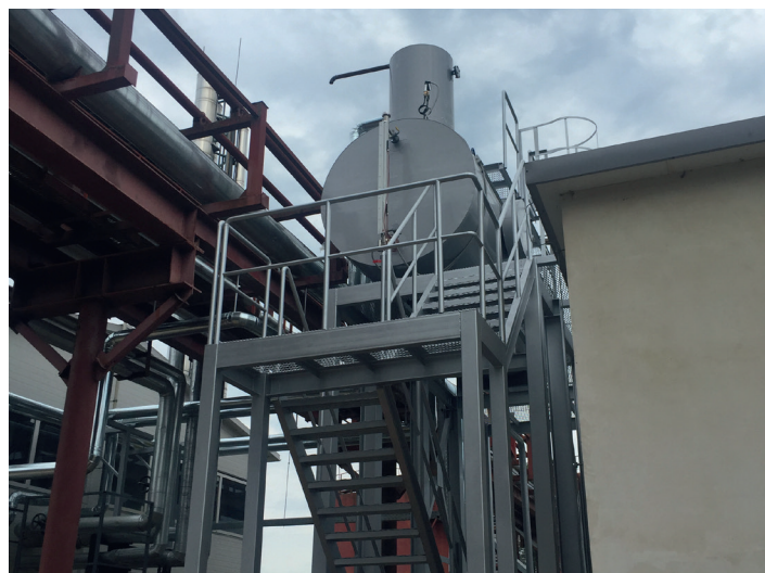
📍 Смоленская область Проектирование, изготовление и монтаж деаэрационного модуля ДА-8 для котельной
